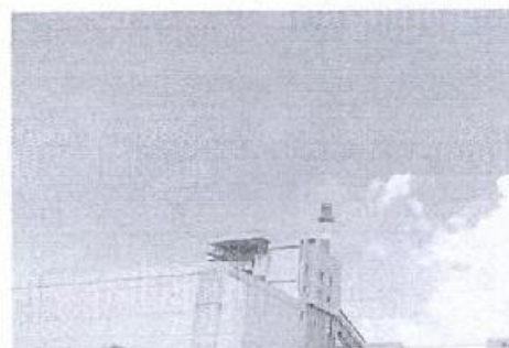
Hình 7: Nhà máy Nhiệt điện Nông Sơn
