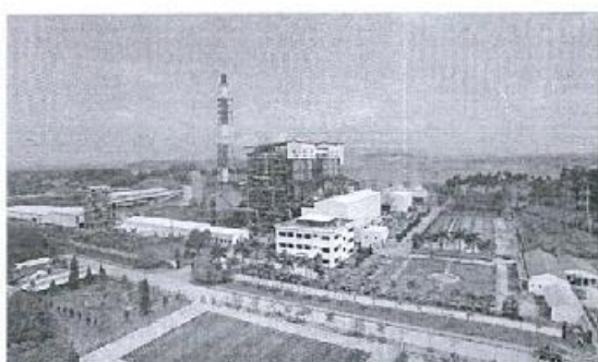
Hình 2: Nhà máy Nhiệt điện Na Dương 1
