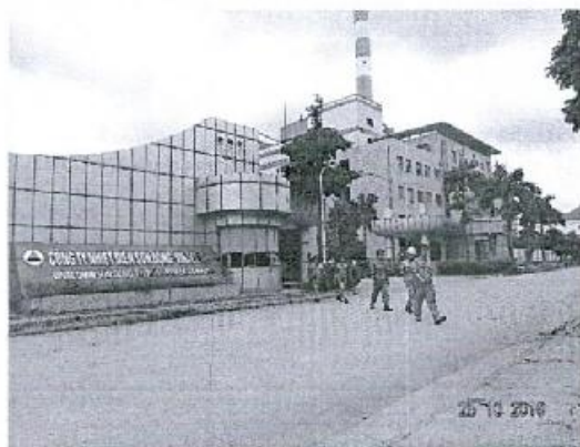
Hình 4: Nhà máy Nhiệt điện Sơn Động
