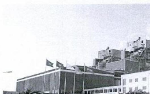
Hình 3: Nhà máy Nhiệt điện Cao Ngạn
