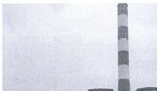
Hình 6: Nhà máy Nhiệt điện Mạo Khê
